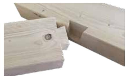
Schwalbenschwanz-Verbindung mit Zulassung
