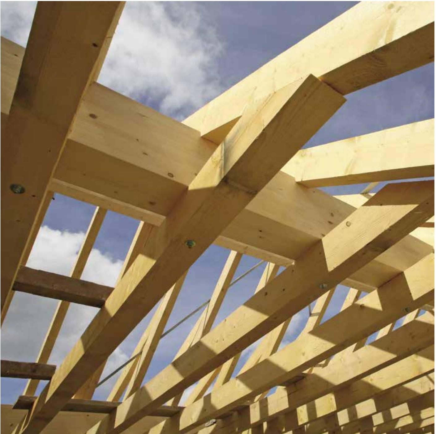
Konstruktionsvollholz wird aus Fichte, nach dem neuesten Stand der Technik hergestellt.
