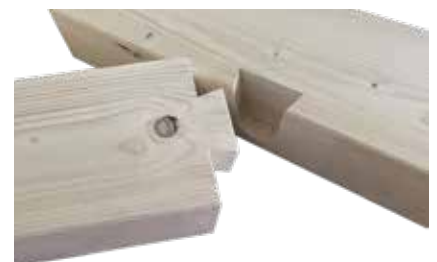
Schwalbenschwanz-Verbindung mit Zulassung
